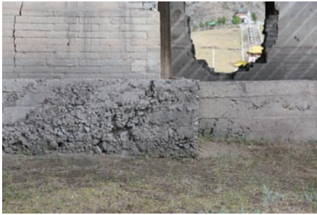
기단부 콘크리트 마감(1)
