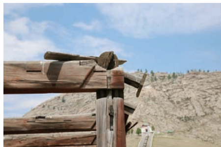
Өндөр баганын дээд хэсгийн дам нуруу ба дээврийн нурууны зангидан холбосон байдал
