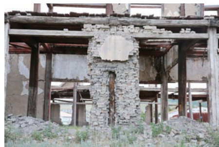
Ханан дотор багана оруулсан байдал
