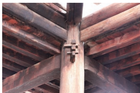
Өндөр баганын ар талын үзүүрийг зангидан холбосон байдал
