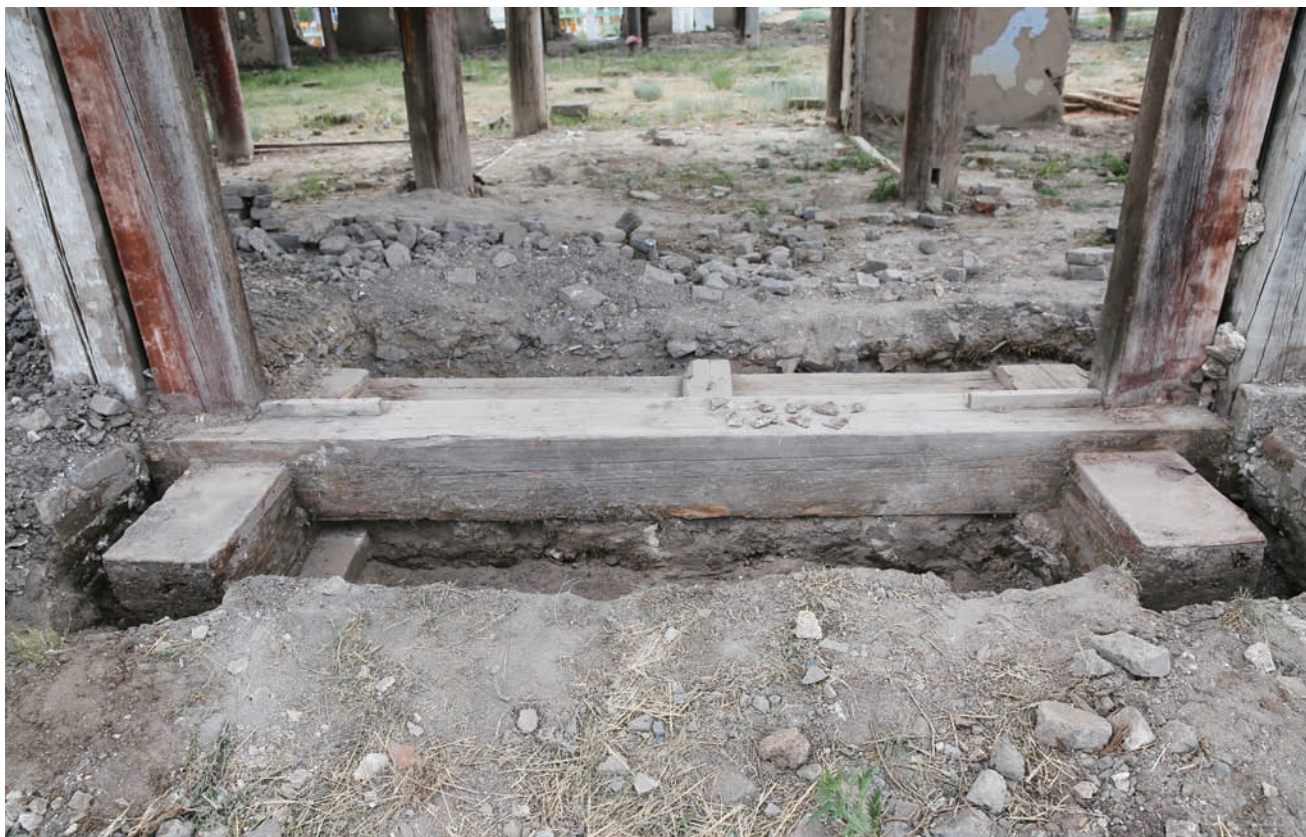
동측 출입문 하부(정면)
