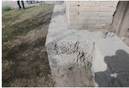
기단부 콘크리트 마감(2)
