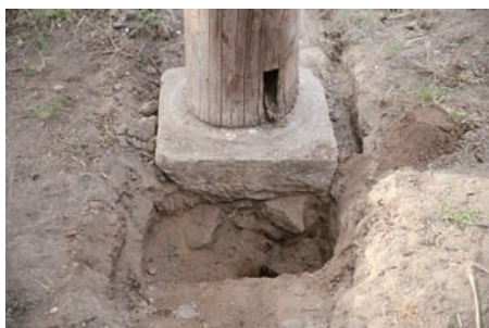
Дөрвөлжин дугуй хэлбэртэй баганын суурь чулуу ба жижиг чулуун суурь
