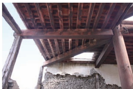
Доод давхрын "гадна талын багана" өндөр баганын хооронд булангийн дам нурууг зангидан холбосон байдал
