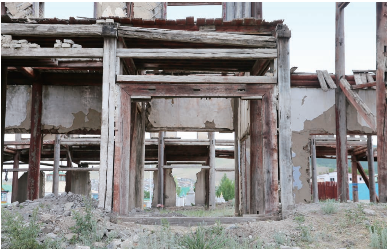
동측 출입문 정면
