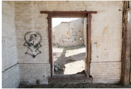
정면 동측 협실 출입문
